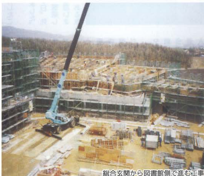
総合玄関から図書館側で進む工事
