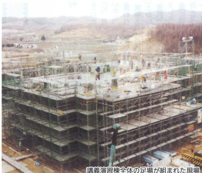
講義演習棟全体の足場が組まれた現場
